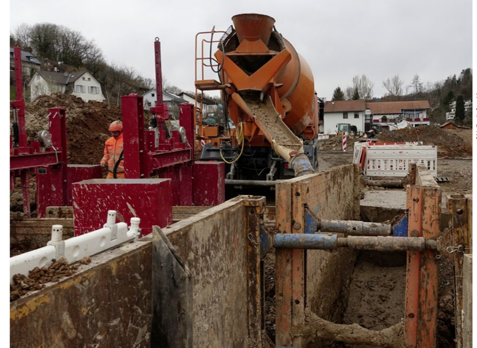
Der Einsatz von Flüssigboden findet in der Schweiz immer grössere Verbreitung. Das Material wird vor Ort wieder eingebaut und behält seine ursprünglichen Bodeneigenschaften.
