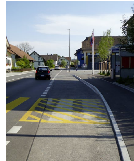
Die Busplatte in Schaffisheim wurde im Zuge der Strassensanierung in Beton ausgeführt.
