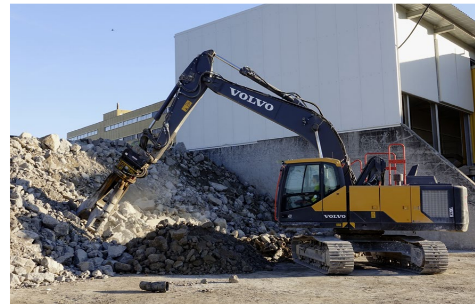
Können die Rückbaumaterialien nicht sofort auf der Baustelle getrennt werden, muss dies in der Recyclinganlage geschehen. Möglichst wenig Material soll auf der Deponie landen.
