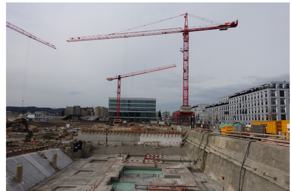
Die Baugrube in Winterthur Hegi grenzt an bestehende Bebauungen und muss gesichert werden.
