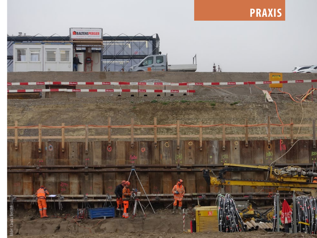
Gründungsarbeiten auf der Baustelle «Three Point» in Dübendorf.
