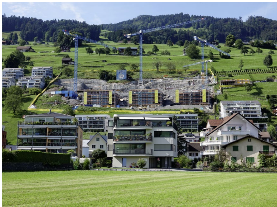
Wohnen am Hang ist beliebt. Die Gründungen liegen aber oft in gefährlichen Rutschzonen.
