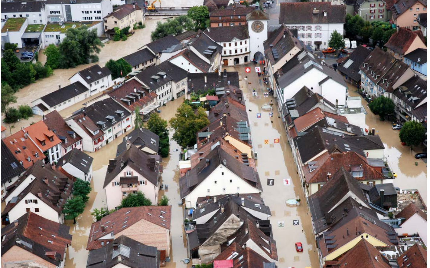
Nach starken Regenfällen traten im August 2007 zahlreiche Bäche und Flüsse über die Ufer. Das Hochwasser überflutete zahlreiche Ortschaften (im Bild Laufen) und unterbrach wichtige Verkehrsverbindungen.
