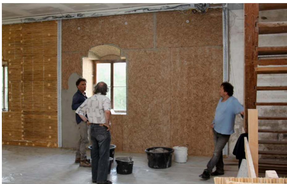
Die unterschiedlichen Innendämmungen (im Bild die Typha-Dämmung) wurden an verschiedenen Stellen angebracht und über einen längeren Zeitraum messtechnisch überwacht.
