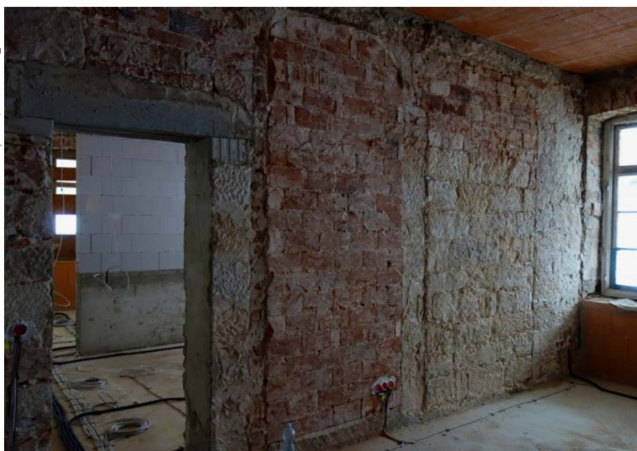
Bei Sanierungen werden meist auch die Fenster erneuert. Zu dicht schliessende Fenster verhindern den Luftaustausch und erhöhen das Risiko von Schimmelbildung an den Innenwänden.
