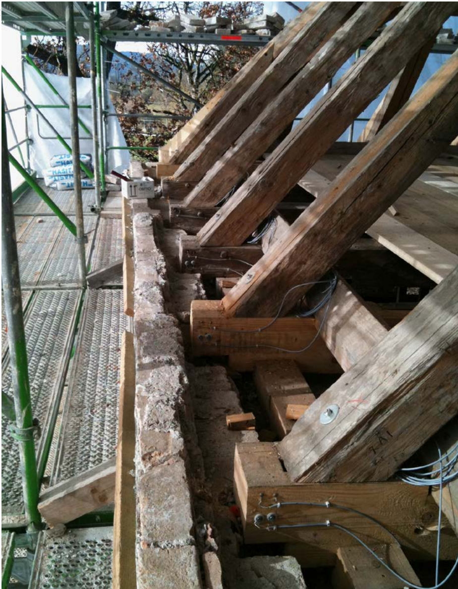
Im Kloster Benediktbeuern wurden die Balkenköpfe mit unterschiedlichen Methoden saniert.
