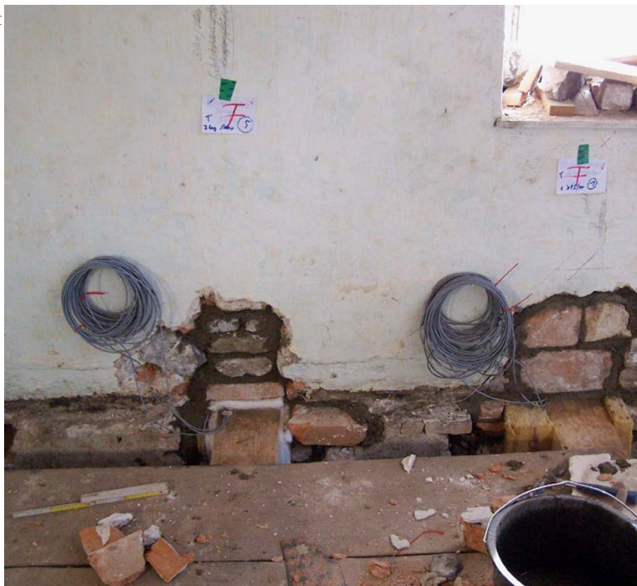
Die sanierten Balkenköpfe wurden mit Sensoren zur Messung der elektrischen Leitfähigkeit versehen.
