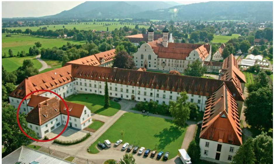
Im Kloster Benediktbeuern werden in der Alten Schäferei verschiedene Sanierungsmethoden an den Holzbalken sowie Wandisolierung geprüft und analysiert.
